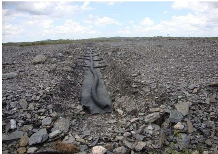
Figura 12 Instalação da tubulação de coleta de lixiviado sobre o substrato B2.
