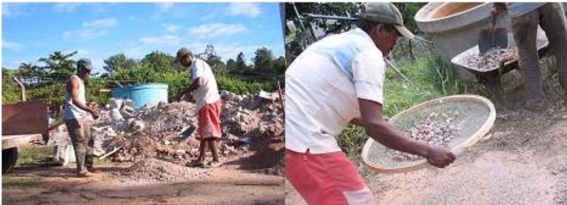
Figura 6 - Peneiramento do material grosseiro em tela de malha de 3,0 cm x 3,0 cm (a) à esquerda e peneiramento do material fino em peneira de malha de 0,5 cm x 0,5 cm (b).à direita.
