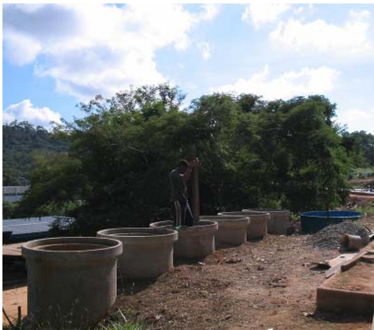
Figura 11 - Vista geral de estrutura experimental constituída pelo reservatório de produção de percolado (ao fundo) e as seis células enfileiradas.
