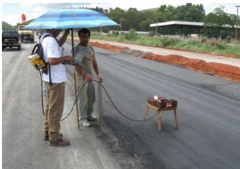
Figura 41. Aspecto do local de estudo: BR040, km 470, Pista Sul.
