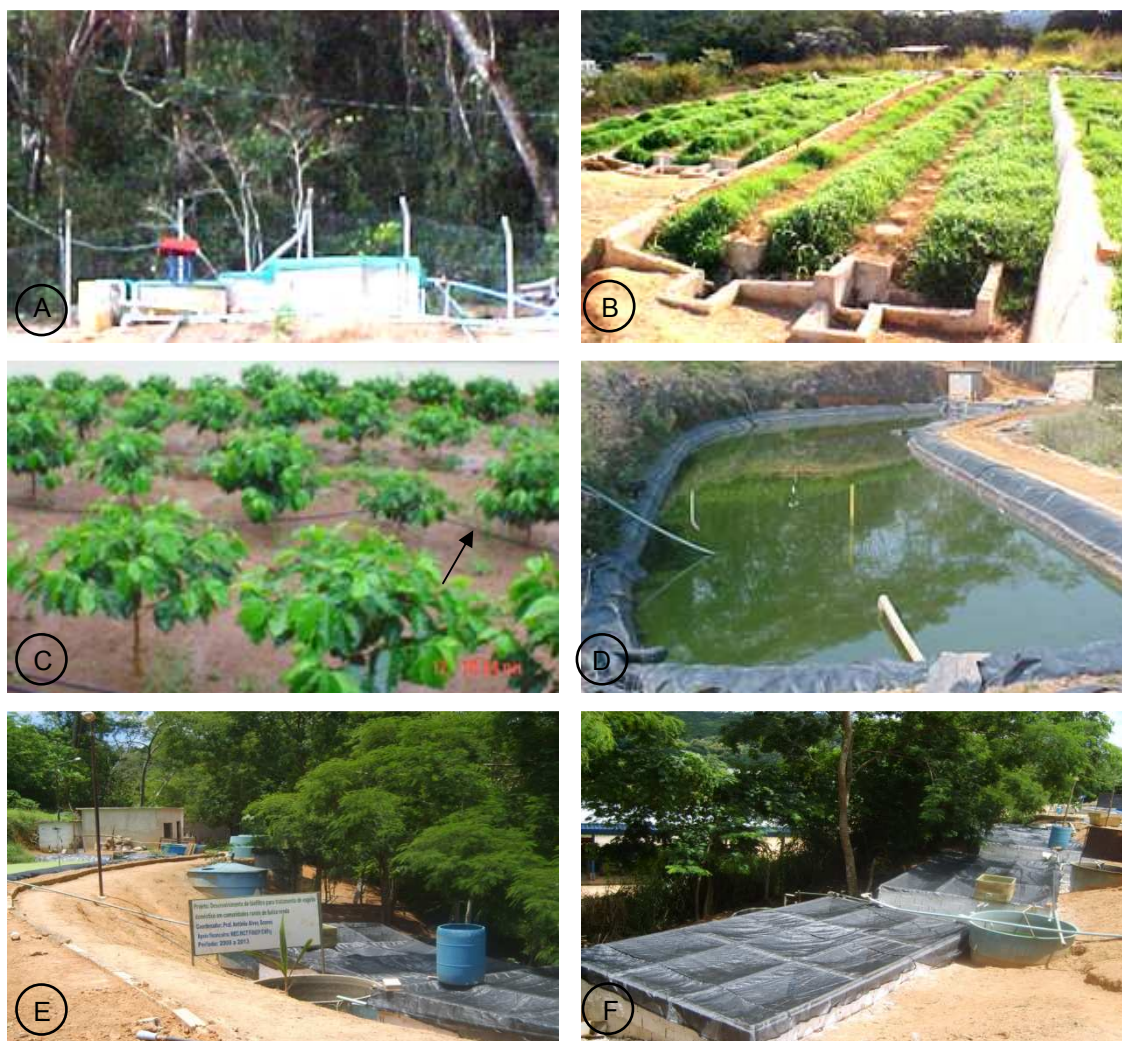
Figura 1 – Tratamentos: preliminar (a); de esgoto doméstico por disposição no solo via escoamento superficial (b); por fertirrigação via gotejamento (c); em lagoa facultativa (d); e por vermifiltros (e) e (f).
