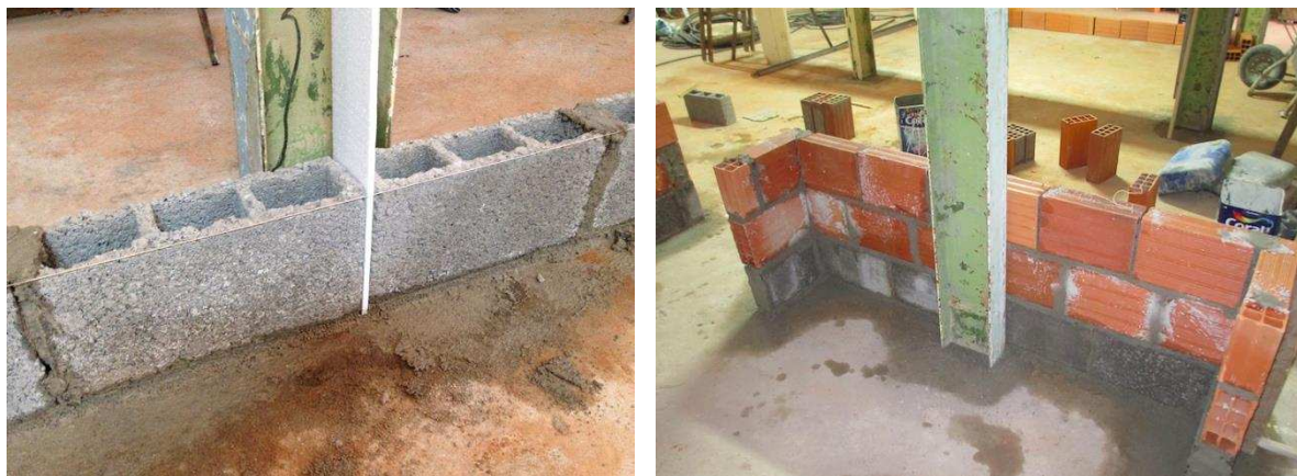
Figura 51 – A assentamento dos blocos: a) primeira fiada em blocos de concreto; b) fiadas subsequentes em blocos cerâmicos furados.
