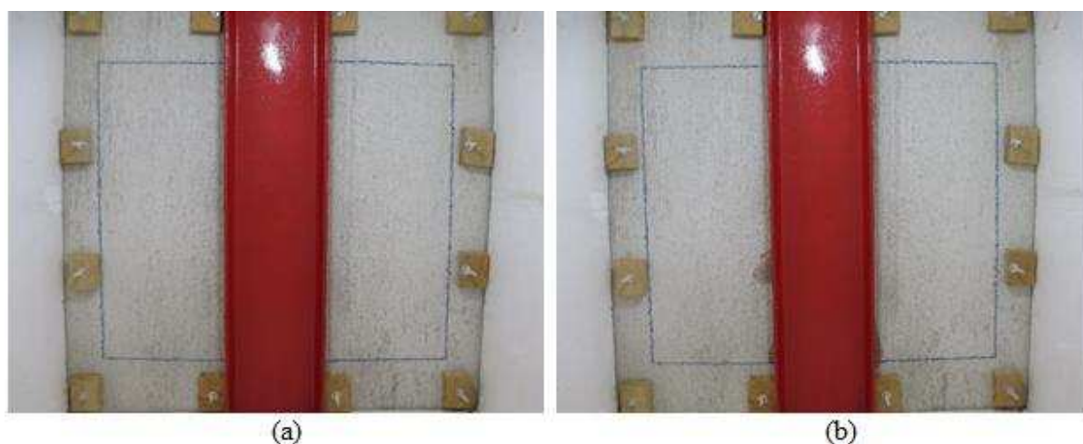
Figura 96 – Face interna do modelo experimental PAR-JV-R2: a) antes do início do ensaio; b) após o término do ensaio.
