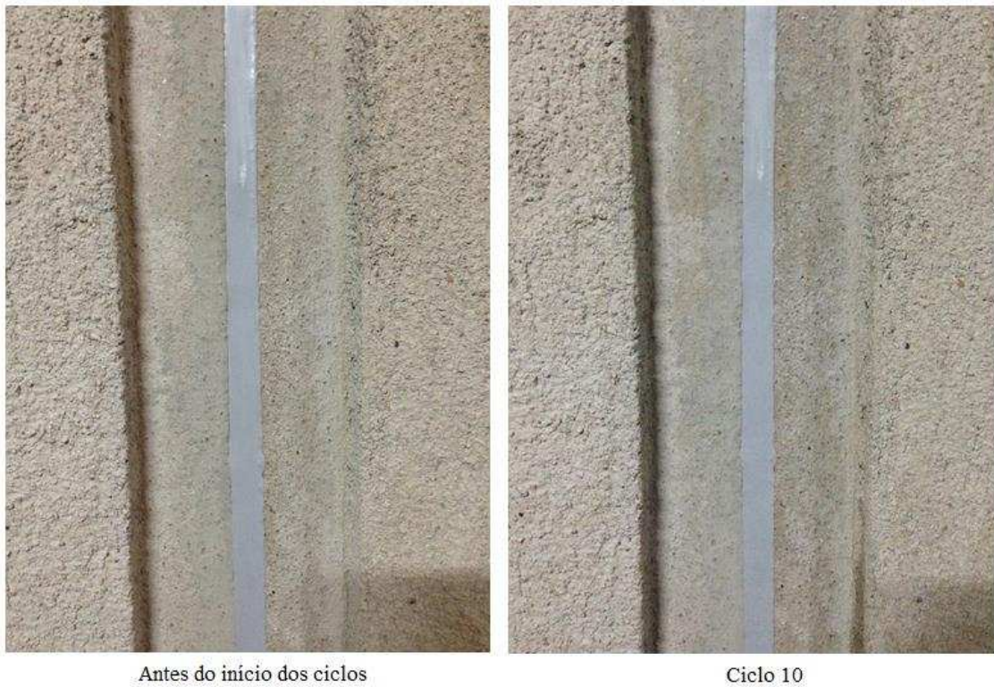
Figura 92 – Detalhe do selante após aquecimento do modelo experimental PAR-JV-R2 na região B indicada.
