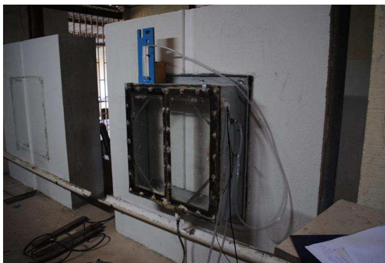
Figura 78 – Câmara de estanqueidade instalada para início ensaio de estanqueidade à água no modelo PAR-JV-R2, pintado com tinta acrílica.
