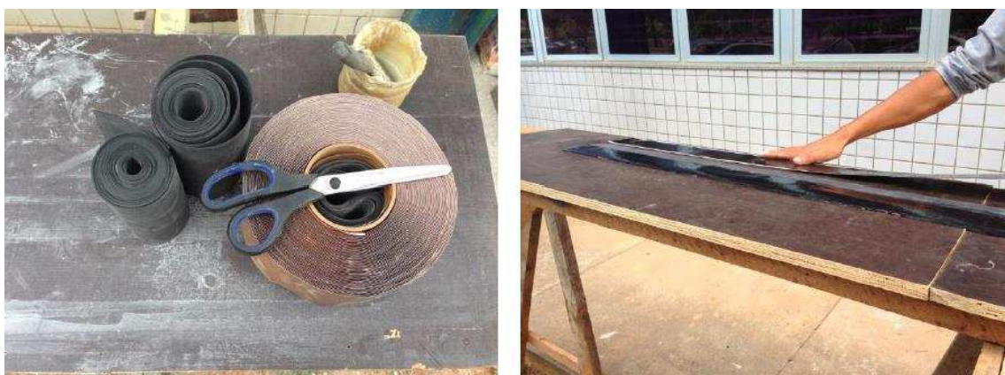
Figura 16 – Manta de elastômero EPDM cortada em faixas (a) e sua preparação antes de ser aplicada (b).
