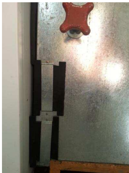
Figura 29 – Placas móveis posicionadas sobre pequenas aberturas no painel radiante.
