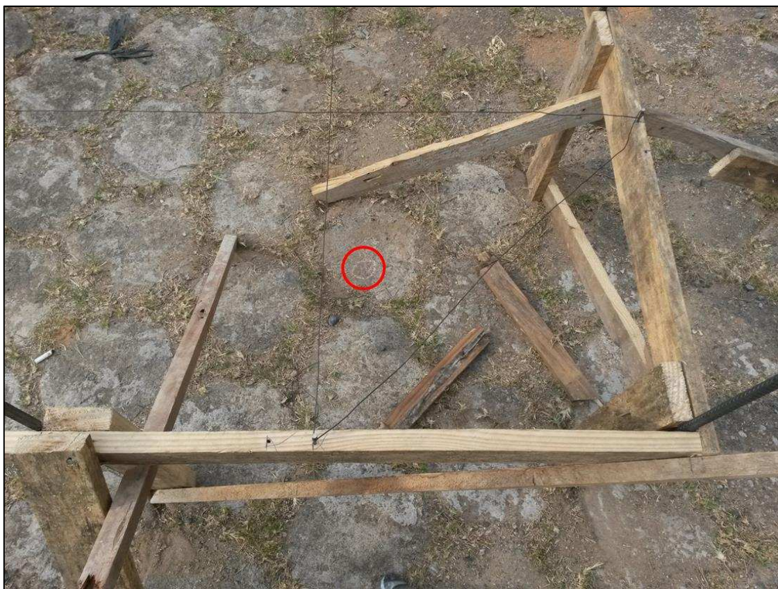
Figura 22 – Locação de um vértice. Fonte: o autor.
