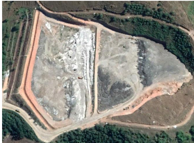
Figura 3 – Vista aérea do aterro da ADAMAG
