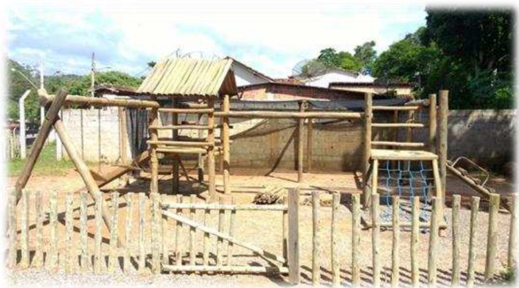
Figura 28 – Parquinho da parte de baixo à esquerda do prédio antigo.
