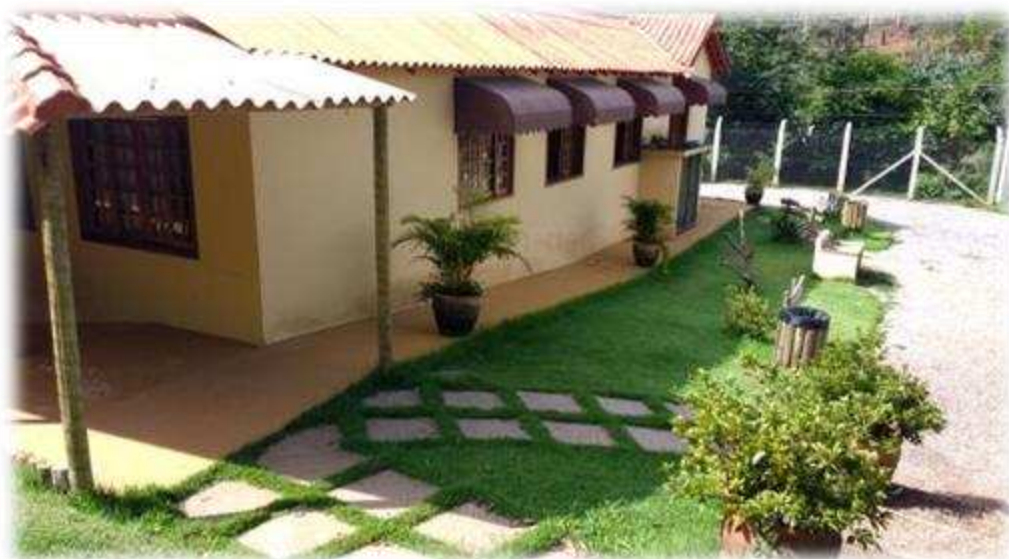
Figura 11 – Vista lateral dos fundos do prédio antigo.
