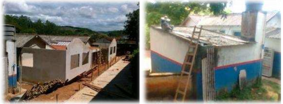
Figura 08 – Reforma do prédio antigo da Escola Jardim da Manga.
