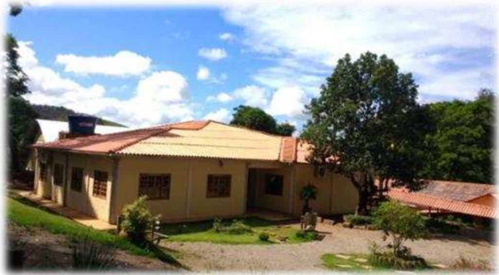
Figura 18 – Prédio novo da Escola Jardim da Manga.
