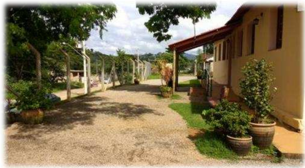
Figura 10 – Vista lateral do prédio antigo.
