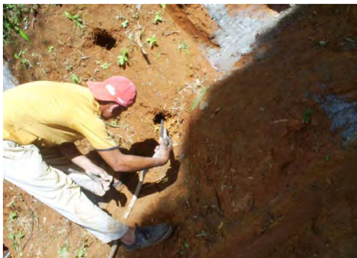
Figura 33. Tubo sendo retirado com o avanço do lançamento com detalhe de calda extravasada no furo superior
