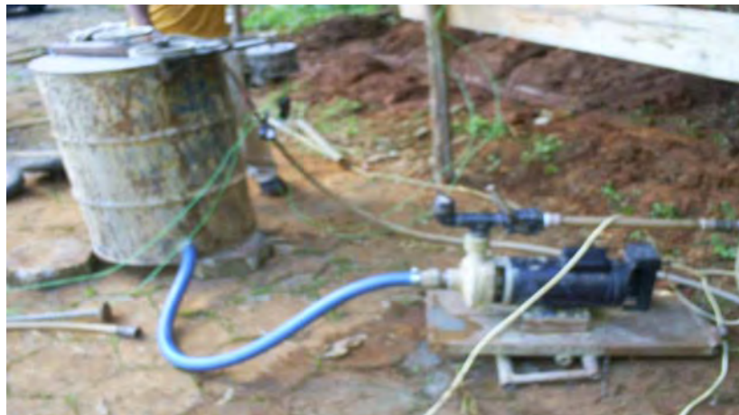
Figura 31. Detalhe Montagem da bomba de lançamento da calda
