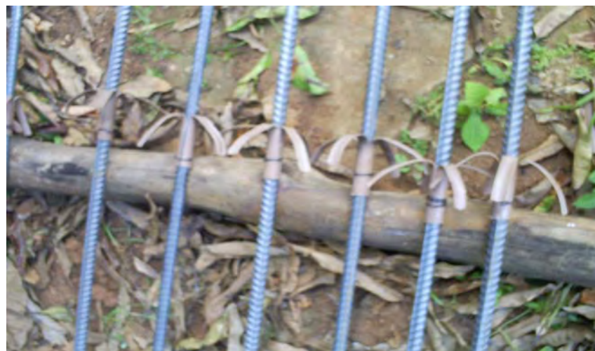
Figura 26. Detalhe amarração do espaçador junto às barras
