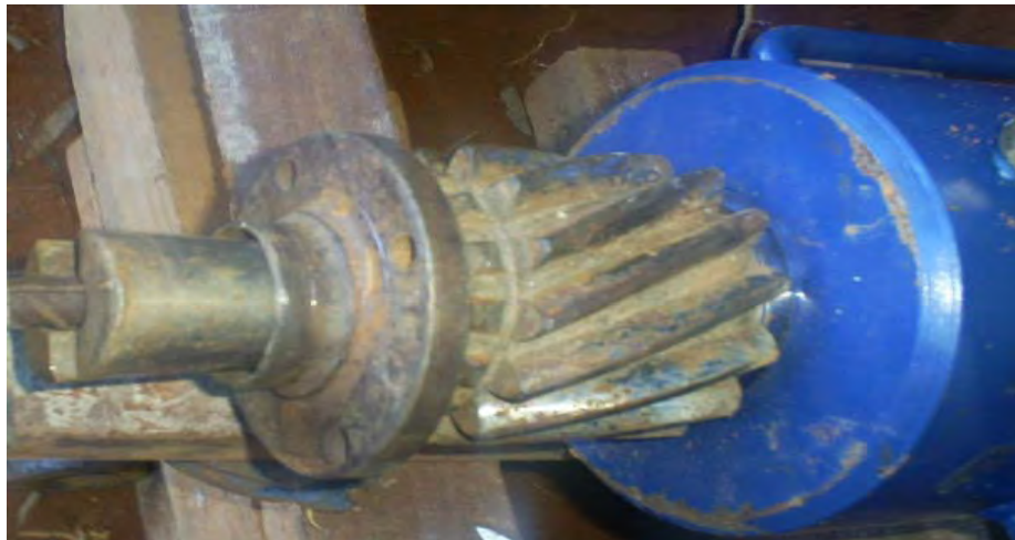
Figura 47. Conjunto de travamento instalado junto à barra
