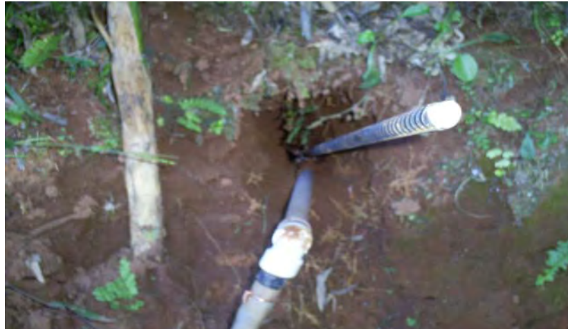
Figura 32. Detalhe ligação mangueira advinda da bomba de lançamento com PVC pré-instalado
