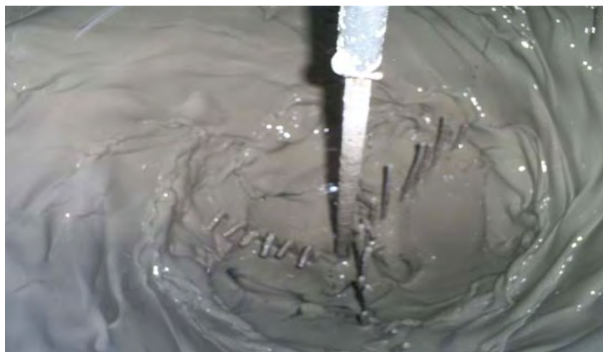
Figura 30. Detalhe calda sendo misturada
