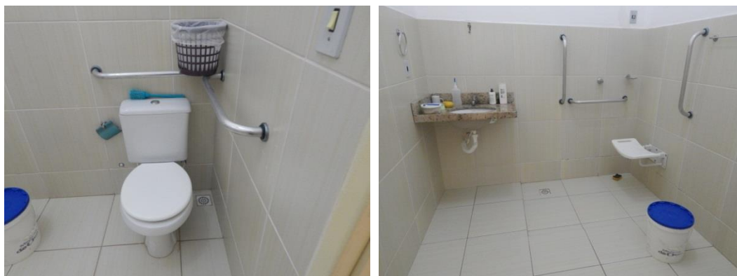
Figuras 16 e 17: Visão interna do banheiro de uma unidade habitacional
