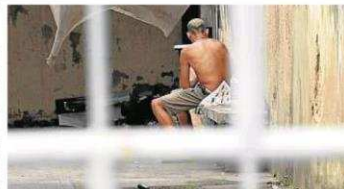
Invasão. Na casa de número 372, bastante deteriorada, um rapaz usa drogas no quintal
