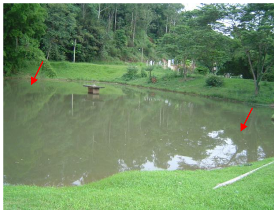
FIGURA 2: Vista parcial da represa em frente ao Supermercado Escola, Campus da UFV, onde estão localizados P1 (margem direita) e P2 (margem esquerda)
