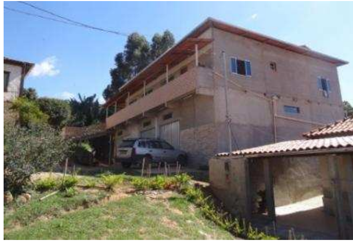
Figura 13 - Estrutura física da fábrica, supermercado e outras atividades Fonte: Acervo do autor
