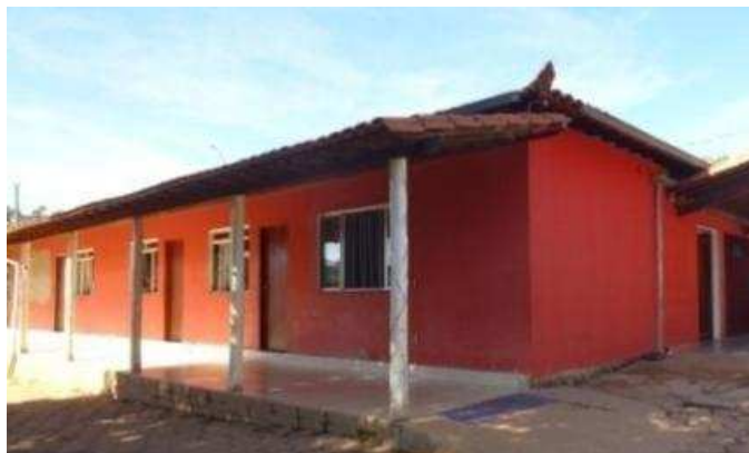
Figura 18 - Casa Mãe ou casa de Delina vista dos fundos Fonte: Acervo do autor
