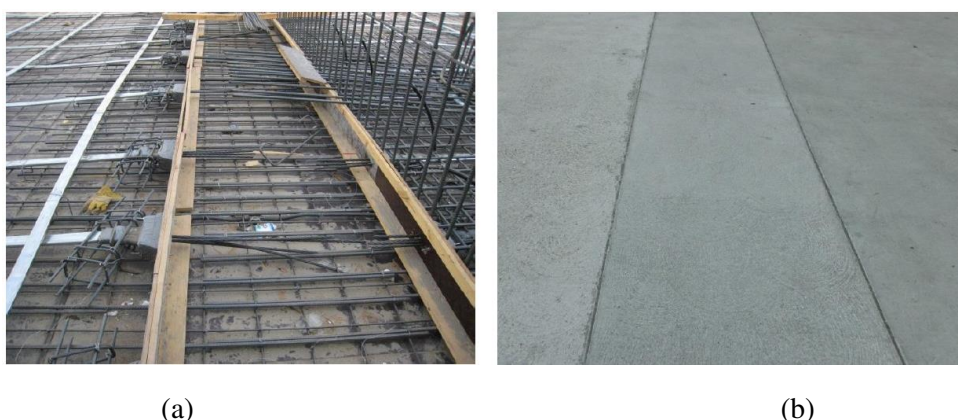
Figura 9 – Faixa de concretagem posterior. (a) faixa aberta; (b) faixa concretada.
