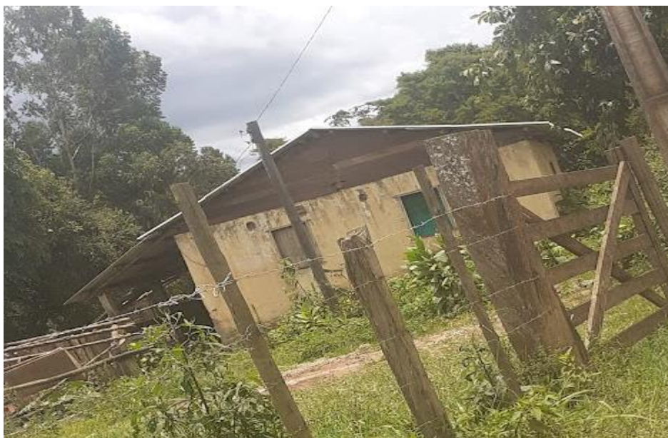
Fotografia 4 - A casa abandonada
