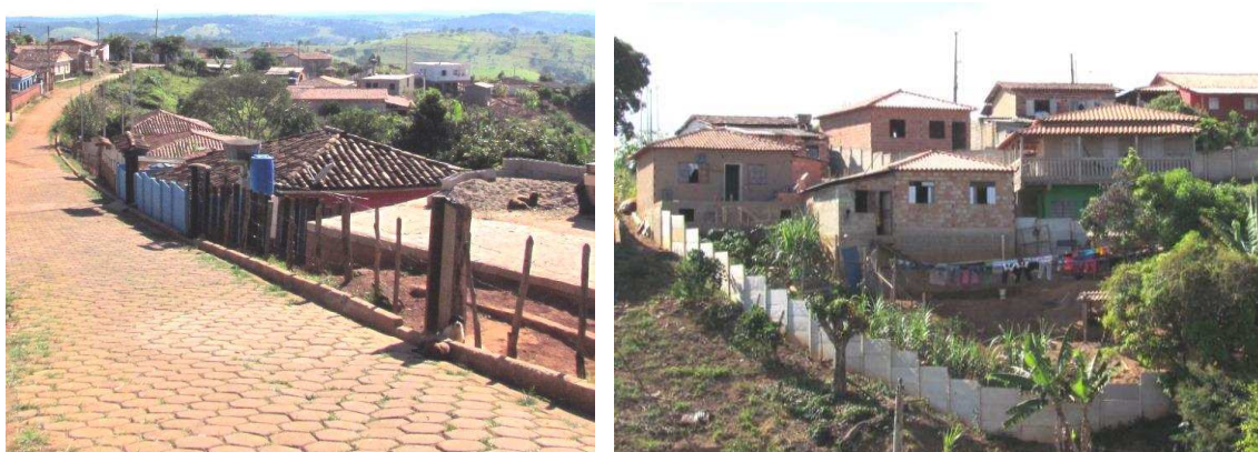
Figura 44 – Ocupação dos aclives e declives em bairros periféricos ilegais.
