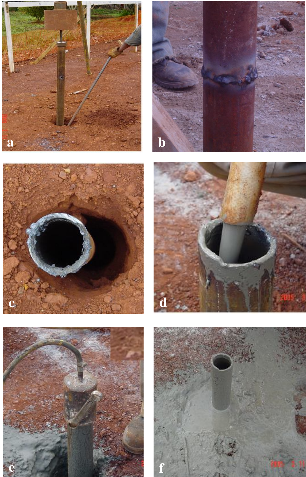
Figura 3.10 – Seqüência construtiva de uma estaca de pequeno diâmetro cravada e injetada
