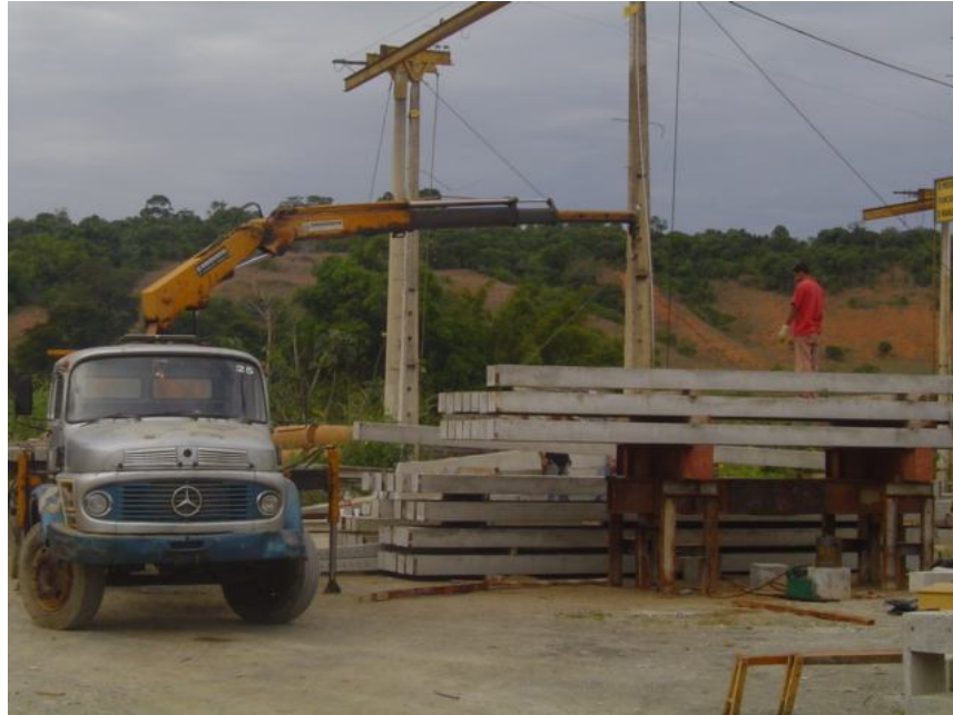
Figura 3.23 – Içamento das estacas de sobrecarga
