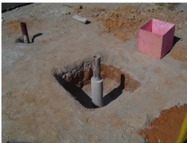
Figura 3.20 – Complemento do fuste com calda de cimento
