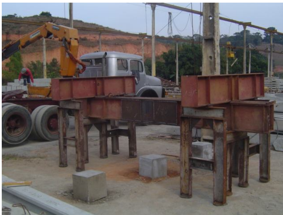
Figura 3.22 – Conjunto de vigas metálicas de reação
