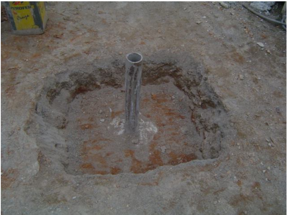
Figura 3.9 – Vista geral de cima de uma estaca executada
