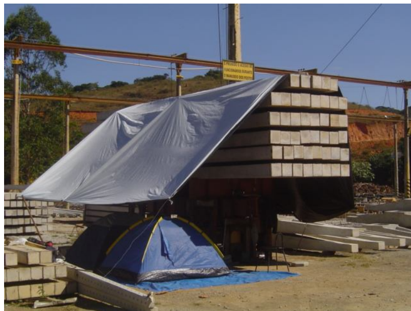
Figura 3.28 – Proteção contra intempéries e área de apoio
