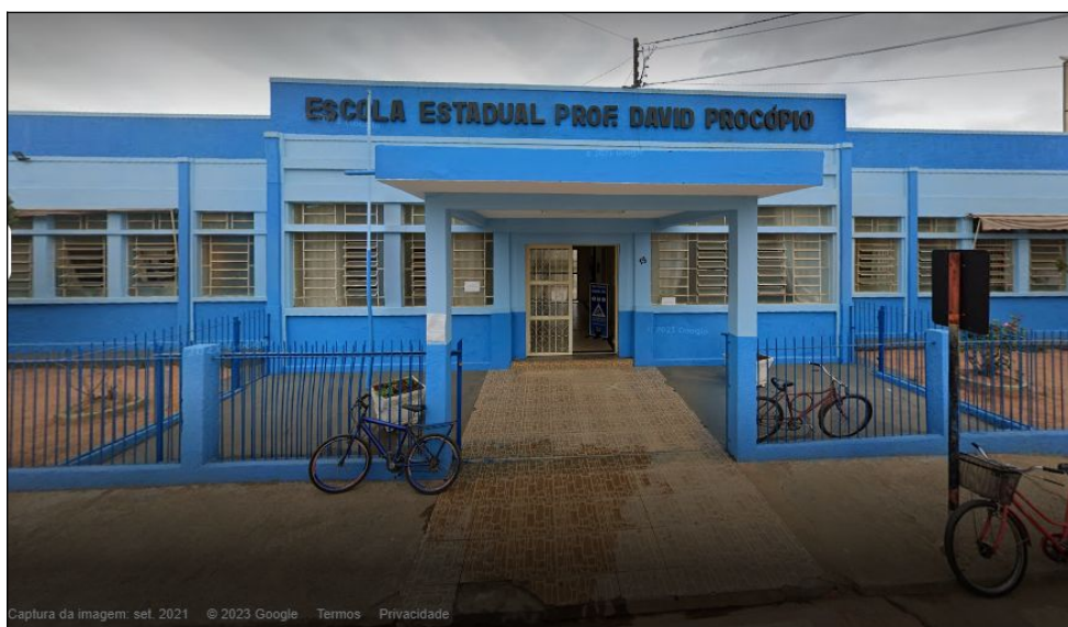
Figura 7 - Vista da entrada da Escola Estadual Professor Davi Procópio.
