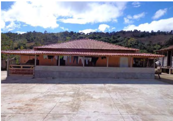
FIGURA 37 – Casa do Respondente 68, após a reforma.
