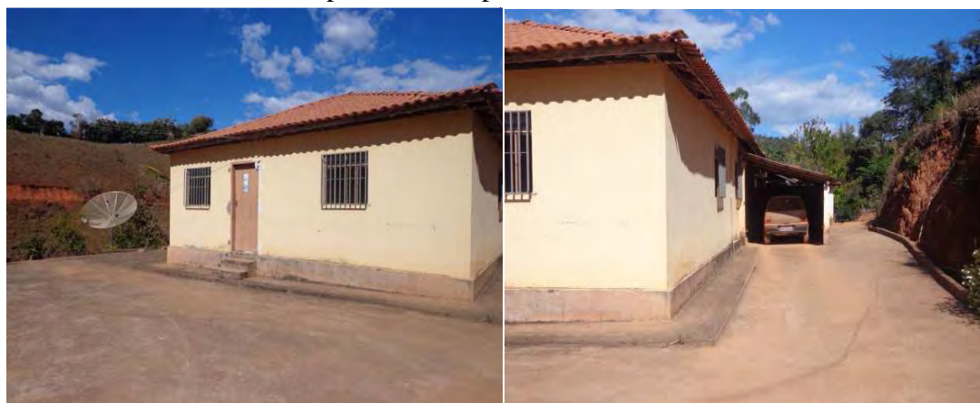
FIGURA 40 – Casa do Respondente 6, após a reforma.
