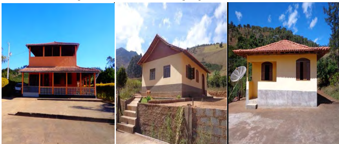
FIGURA 26 – Arquitetura das casas em Araponga, MG.
