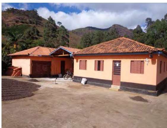
FIGURA 33 – Casa da Respondente 43, após a reforma.
