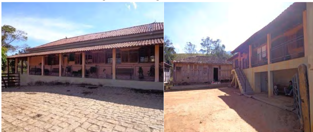
FIGURA 35 – Casa do Respondente 29, após a reforma.
