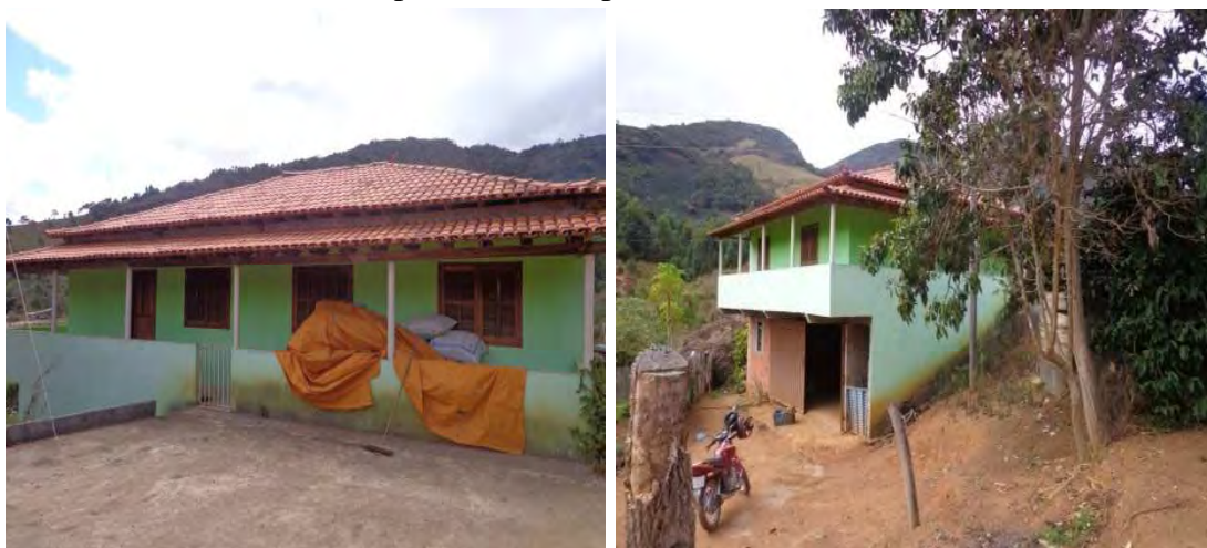
FIGURA 36 – Casa da Respondente 62, após a reforma.
