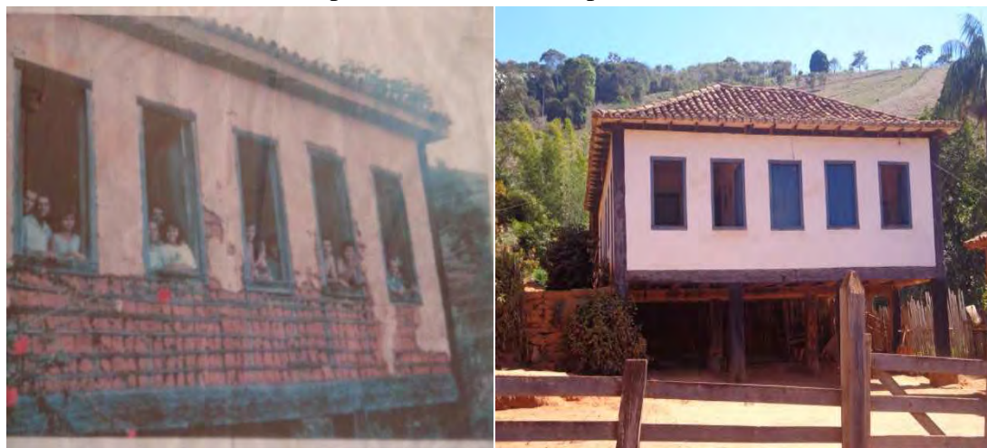
FIGURA 43 – Casa da Respondente 11, antes e após a reforma.
