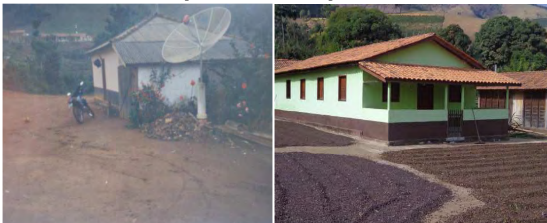
FIGURA 28 – Casa da Respondente 32, antes e após a reforma.
