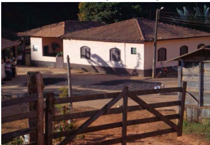
FIGURA 39 – Casa do Respondente 5, após a reforma.
