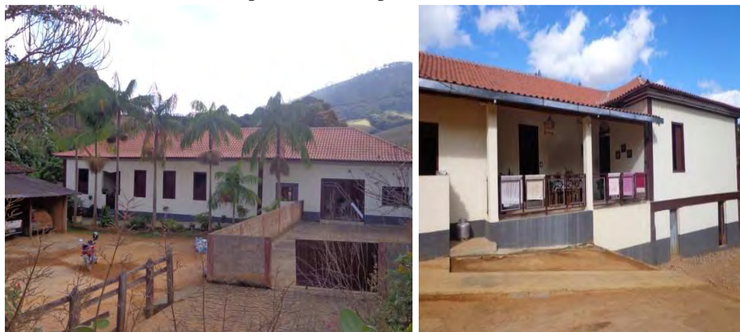
FIGURA 41 – Casa do Respondente 27, após a reforma.
