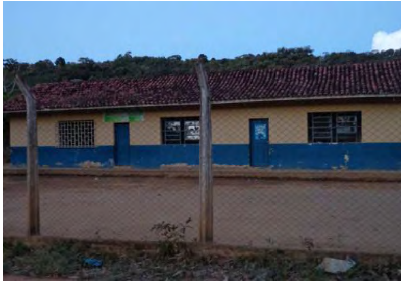
FIGURA 22 – Escola Municipal, localizada na comunidade de São Joaquim, Araponga, MG.
