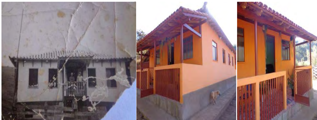
FIGURA 32 – Casa da Respondente 13, antes e após a reforma.
