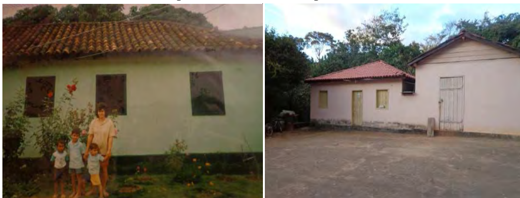
FIGURA 30 – Casa do Respondente 10, antes e após a reforma.
