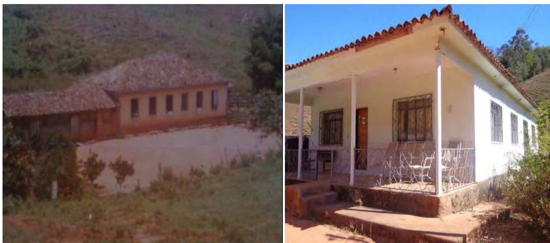
FIGURA 29 – Casa da Respondente 7, antes e após a reforma.
