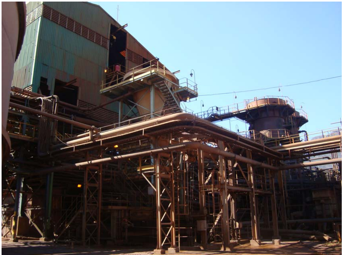
Figura 3.9: Vista geral do cone desaguador do rejeito da separação magnética
