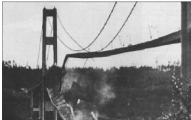
Figura 3 – Ponte de Tacoma Narrows após o efeito da ressonância
