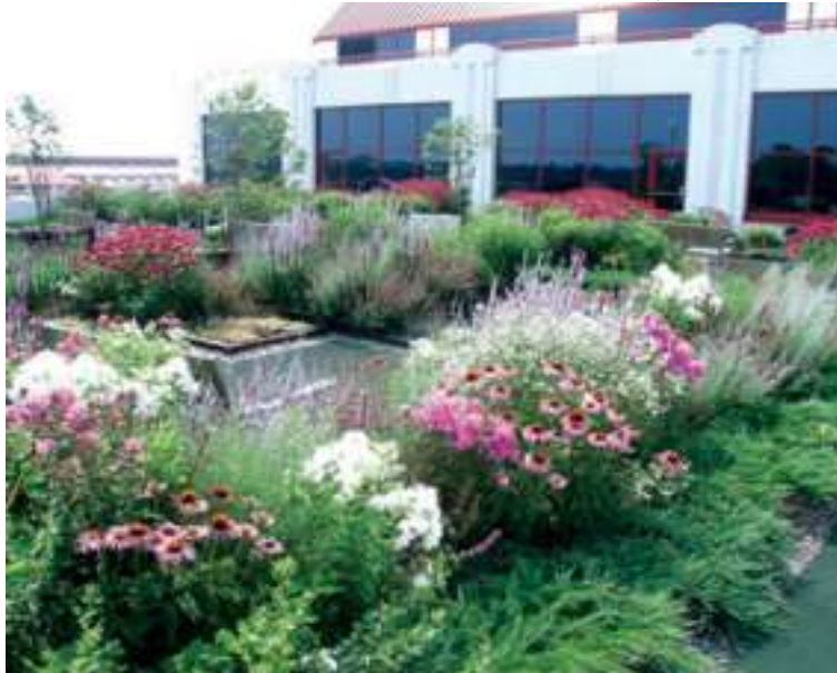
Figura 11 - Sistema Intensivo em um edifício em Beloit, USA
