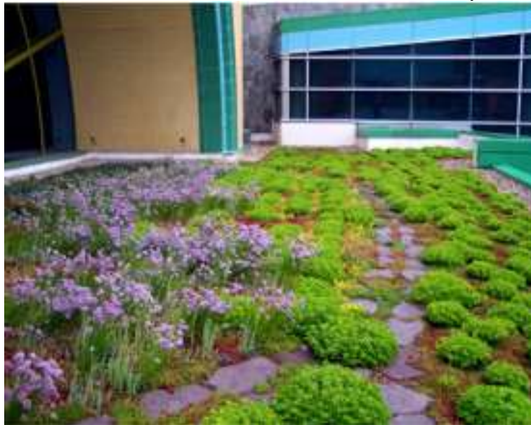
Figura 17 - Sistema de telhado verde semi-intensivo - Indianópolis, USA
