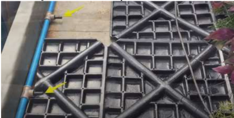
Figura 44 - Gotejadores em sistema flat para telhado verde.
