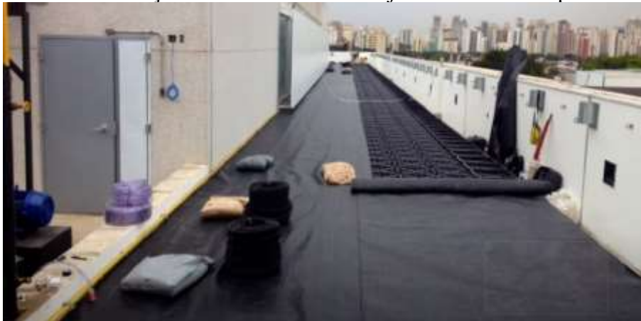
Figura 41 - Distribuição da tela sobre as bandejas no sistema flat para telhado verde
