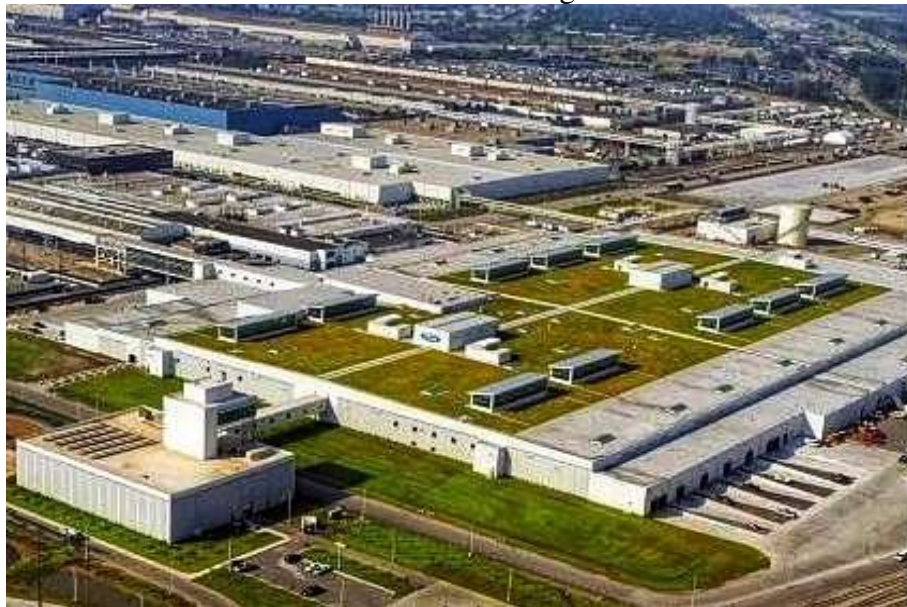
Figura 57 - Telhado verde fábrica Ford – Michigan
