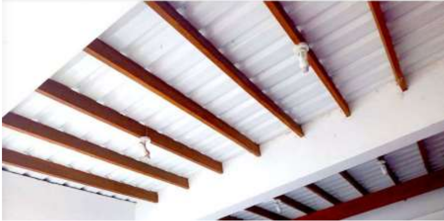
Figura 50 - Sistema Kaatop, visto por baixo
