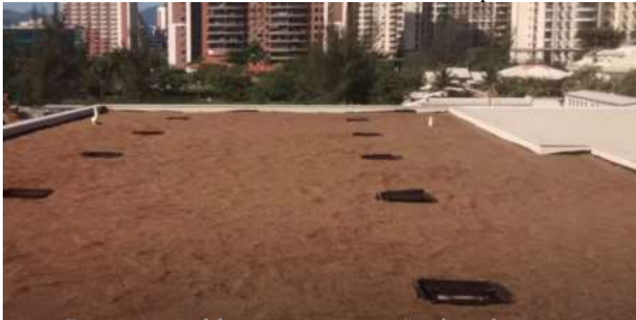
Figura 43 - Preenchimento com substrato no sistema flat para telhado verde
