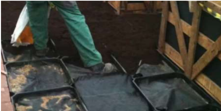
Figura 29 - Preenchimento com substrato
