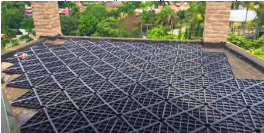
Figura 40 - Distribuição das bandejas de drenagem no sistema flat para telhado verde
