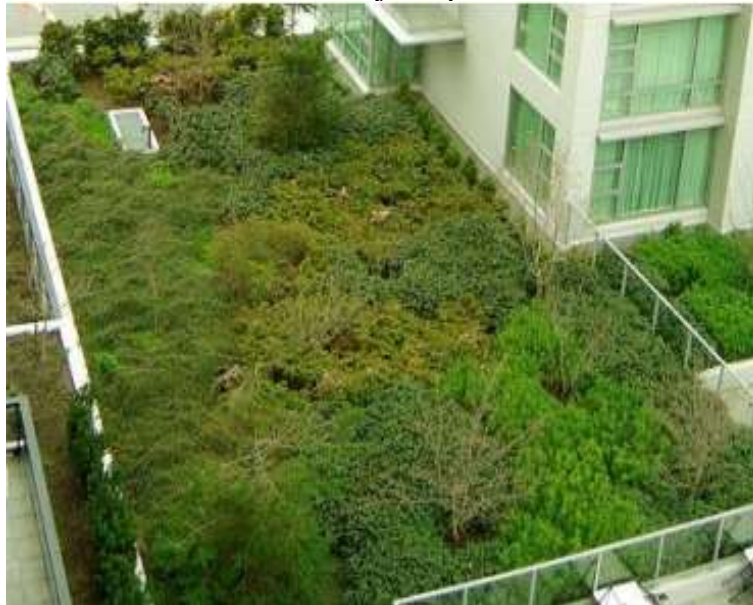
Figura 9 - Sistema intensivo em uma laje de prédio
