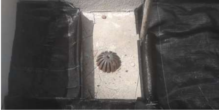
Figura 42 - Ralos abertos no sistema flat para telhado verde
