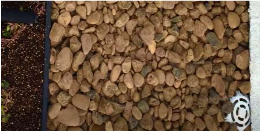
Figura 31 - Preenchimento dos compartimentos do ralo com seixos de alta granulometria
