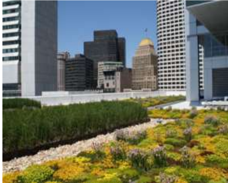
Figura 18 - Sistema de telhado verde semi-intensivo - Boston, USA
