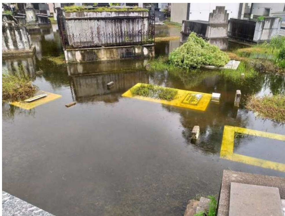
Figura 66 - Falta de drenagem em períodos chuvosos no cemitério.
