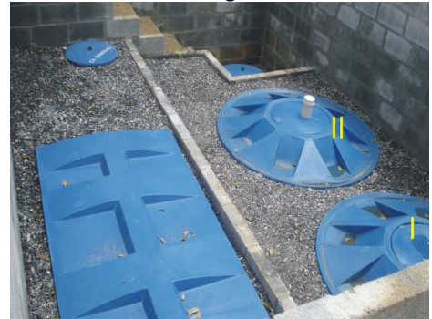
D – Fossa séptica (I) e filtro anaeróbio (II) após a instalação
