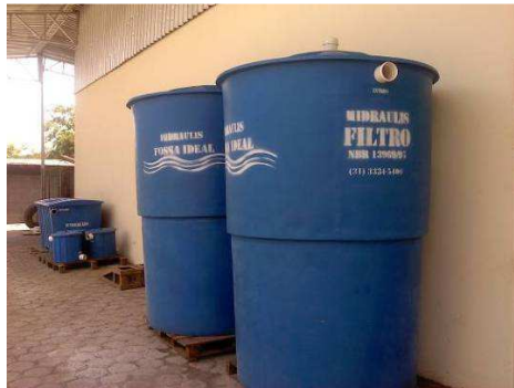
E – Fossa séptica e filtro anaeróbio antes de instalação
