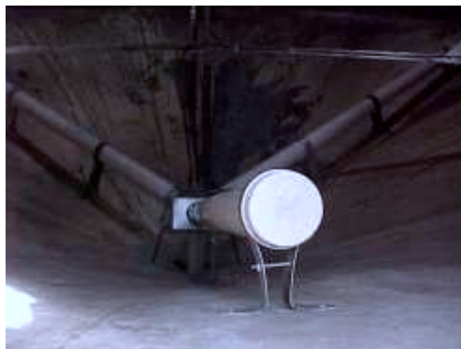
Figura 2 - Distribuição dos dutos de aeração montados no interior do silo experimental.
