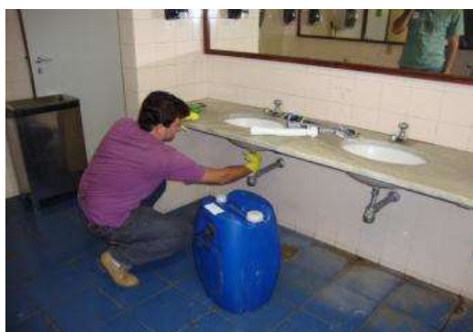
Figura 5 - Instalação de recipientes coletores em pias de banheiro.
