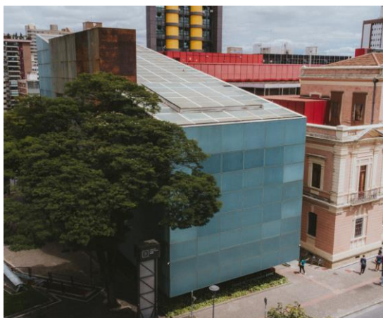
Figura 4 – Fachada do prédio
