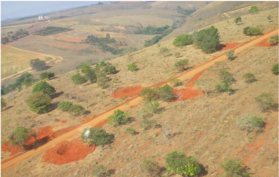
Figura 1 – Bacias de acumulação para a contenção do escoamento superficial em estradas não pavimentadas.
