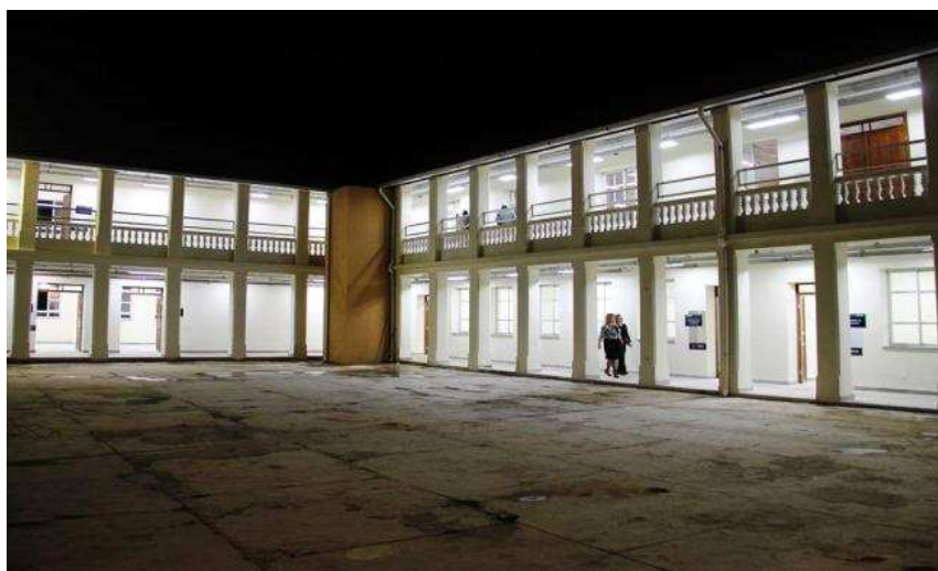
Salas e corredores do Colégio após reforma. Fonte: https://www.vicosanews.com
