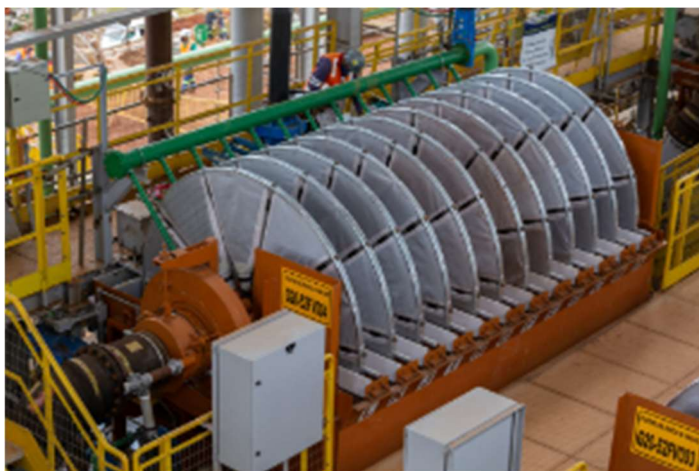
Figura 5.7 - Filtro de rejeito a vácuo - Samarco
