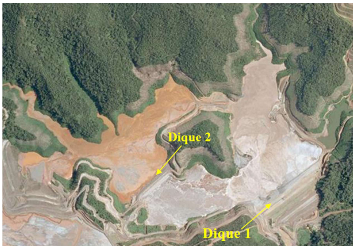
Figura 6.1 - Barragem Fundão e seus diques
