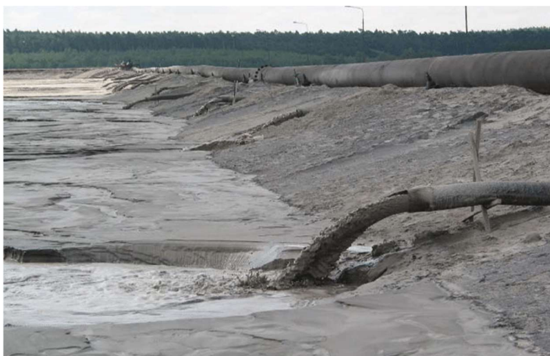
Figura 5.5 - Espigotamento de rejeito
