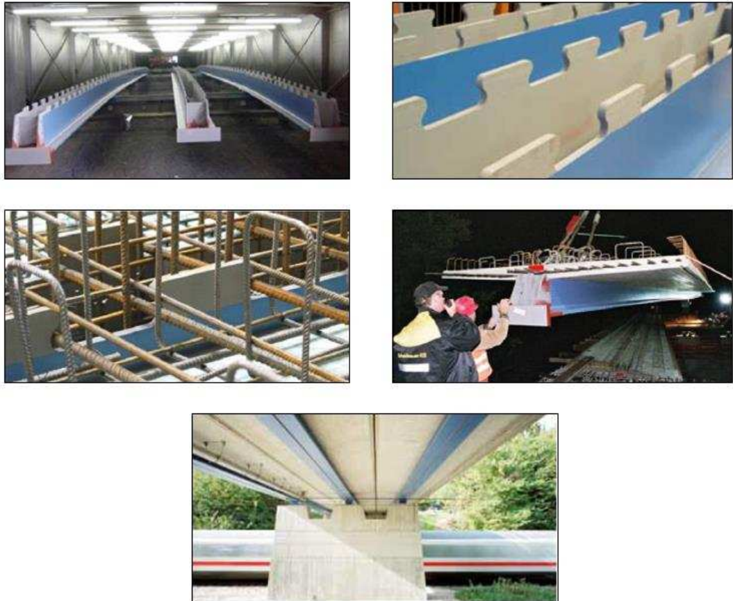
Figura 45. Construção da primeira ponte com composite dowels , na cidade de Pöcking.
