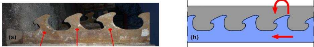
Figura 3. Falha no conector desencadeada por um mecanismo combinado de cisalhamento e flexão.
