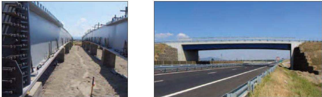
Figura 48. Ponte rodoviária na Romênia, utilizando conectores MCL.
