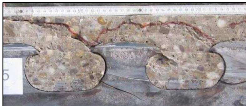
Figura 3. Falha da conexão por pry-out do concreto em conectores MCL.
