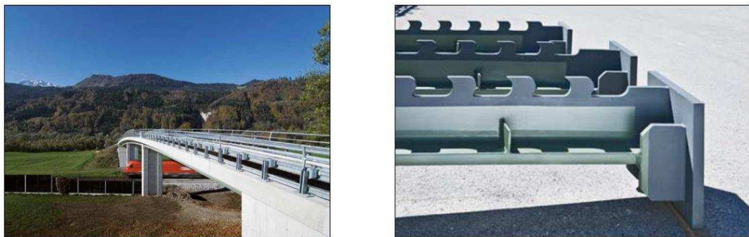
Figura 46. Ponte na cidade de Vigaun, na Áustria, com conectores barbatana.
