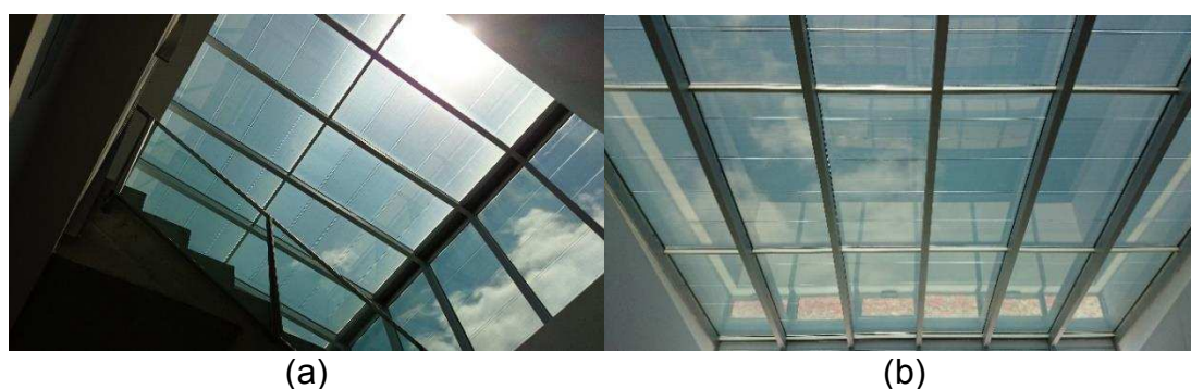
Figura 7.4. Sistemas solares fotovoltaicos instalados na cobertura do Edifício Lucia. (a) subsistemas 2 e 3 e (b) subsistema 4.
