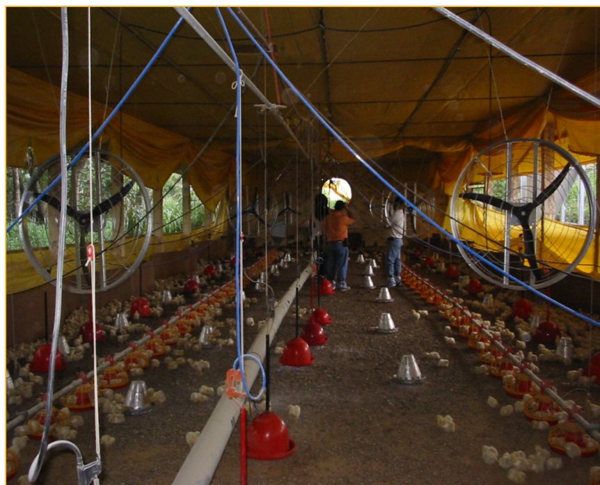
Figura 01 B: Vista interna do galpão equipado com sistema de ventilação em modo túnel, mostrando a disposição dos ventiladores.
