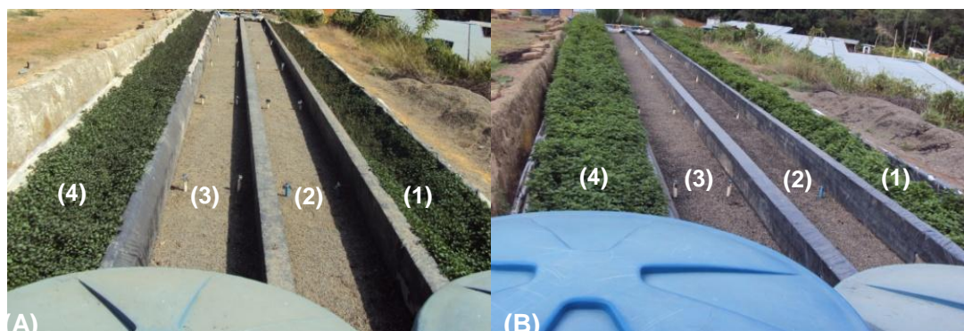
Figura 8: Vista dos SACs-EHSS ao final da primeira (A) e da segunda (B) etapa experimental.
