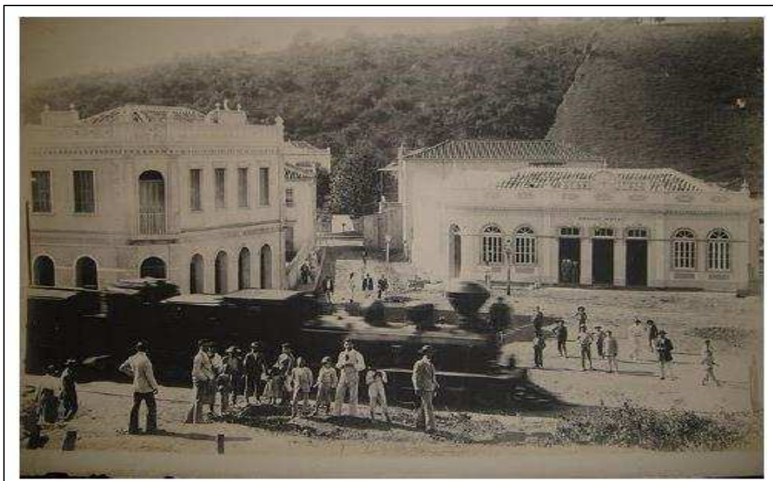
Figura 9: Linha férrea no centro da cidade, próximo de onde viria se construir a estação – 1914
