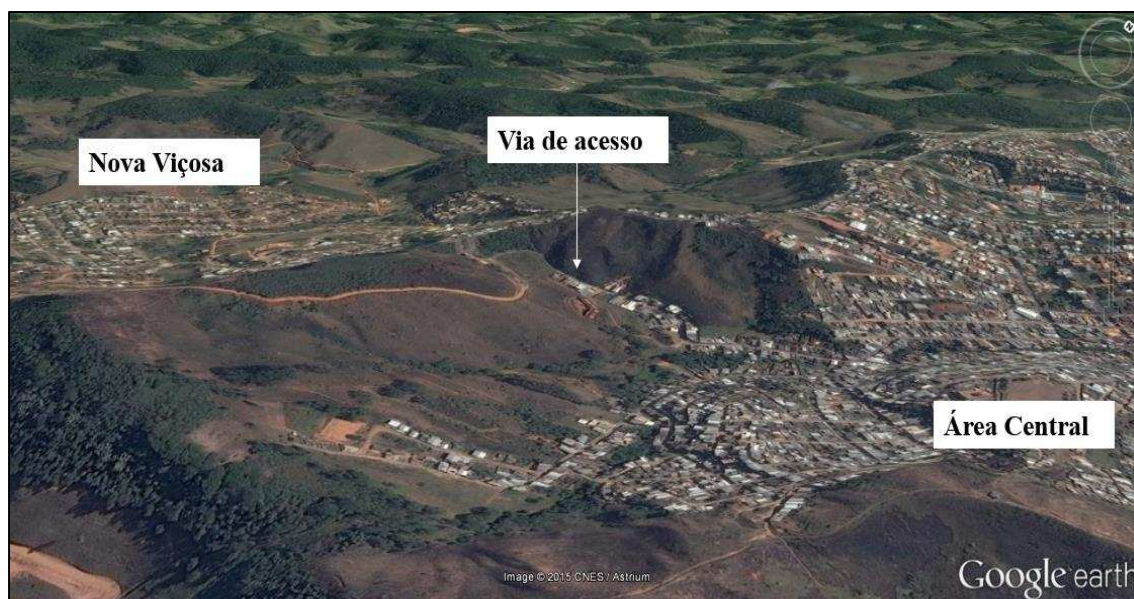
Figura 15: Distância entre o Bairro Nova Viçosa e o centro da cidade
