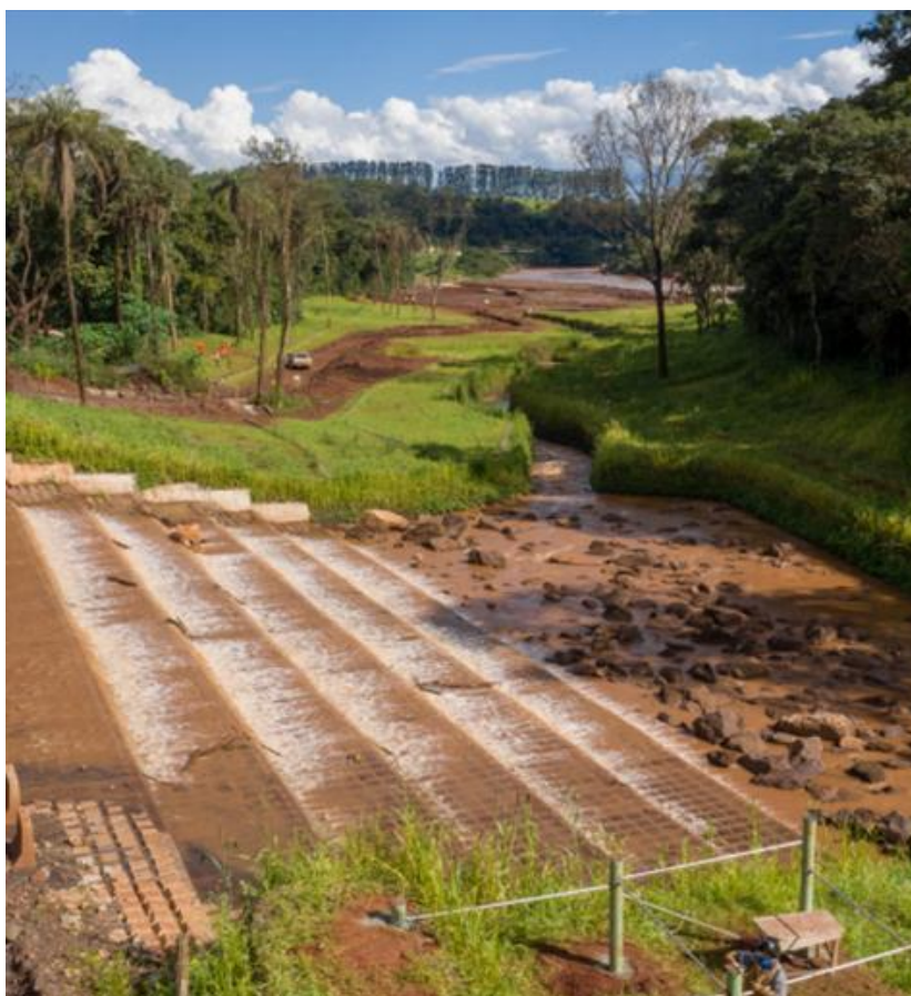
Figura 2. Registro da área do projeto de reabilitação da calha do Ribeirão Ferro-Carvão, denominada Marco Zero, em Brumadinho MG. Foto: arquivo Vale (2020).
