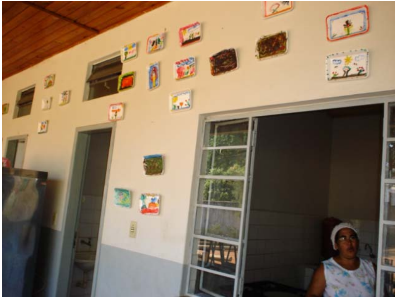
Figura 7- Vista parcial da fachada da escola. Podem ser observados parte da cantina e do banheiro.
