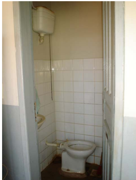
Figura 8- Banheiro da escola.
