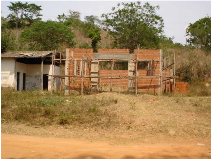
Figura 13- Construção da igreja do assentamento.
