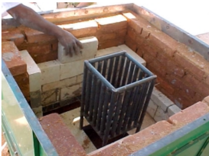
Figura 24 - Assentamento de tijolos refratários na câmara de combustão sobre parede de meio-tijolo maciço. No centro, posicionamento da célula de queima e abertura para passagem das cinzas.
