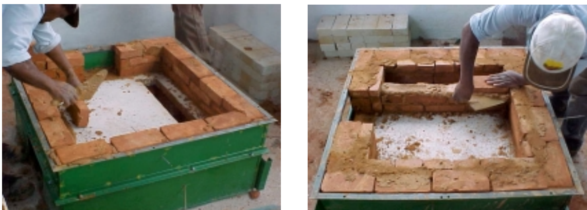
Figura 22 - Assentamento de tijolos no compartimento cinzeiro (módulo 2).
