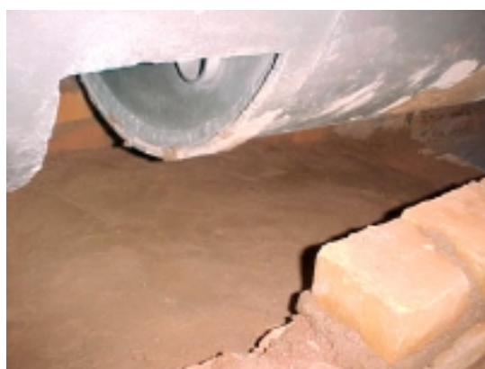
Figura 56 - Rampa para condução dos gases até a entrada do feixe tubular.
