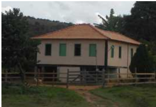
Figura 34: Casa com as paredes reformadas e pintadas com tinta, Piranga, MG.
