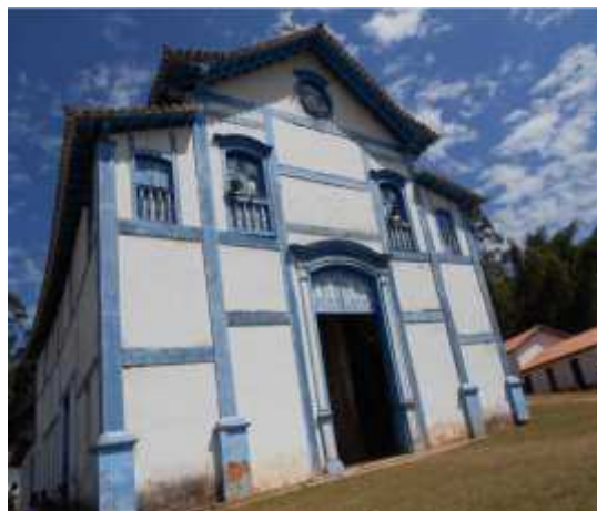
Figura 6: Santuário do Senhor Bom Jesus de Matozinhos em Piranga tombado pelo IPHAN.
