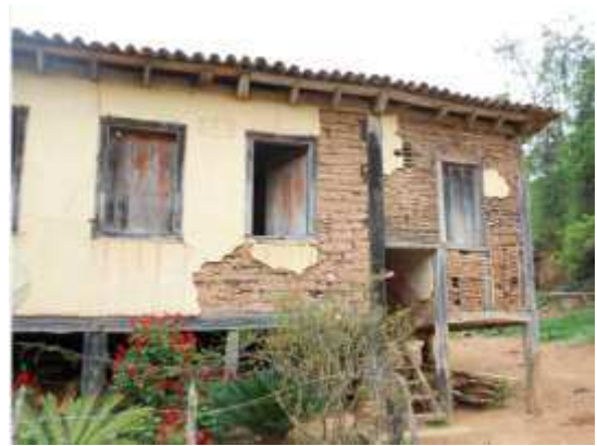
Figura 33: Fachada da casa com as paredes barreadas, Piranga, MG.
