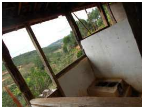
Figura 80: Estrutura dos cômodos que os idosos “ranchavam”, Piranga, MG.
