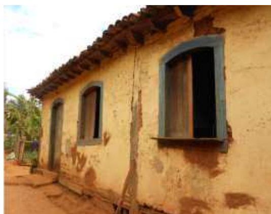
Figura 31: Fachada da casa barreada e pintada com barro amarelo, Piranga, MG
