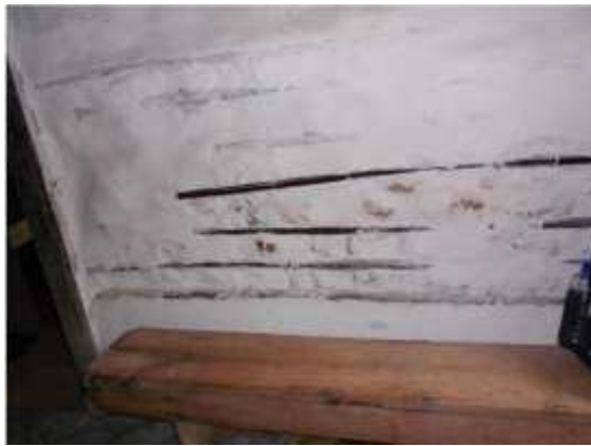
Figura 32: Parede barreada e pintada com barro branco, Piranga, MG.
