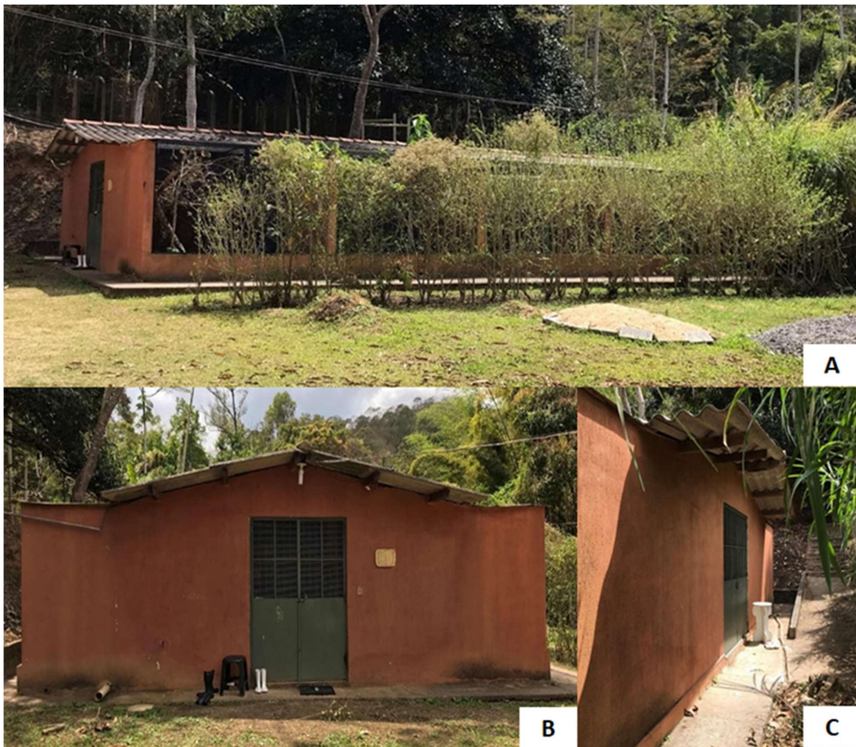
Figura 1 – Galpão de recintos do CCSS (A); entrada da frente (B); entrada dos fundos (C).
