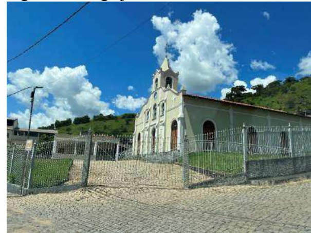
Figura 294 – Igreja de São Sebastião
