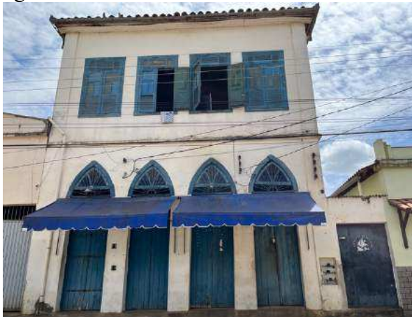
Figura 263 – Sobrado com portas em arco ogival
