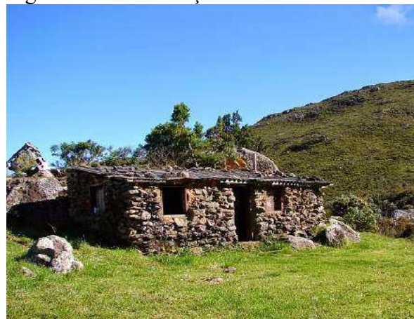
Figura 178 – Edificação de Pedra
