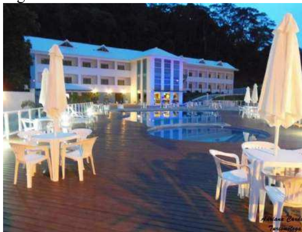
Figura 272 – Fachada do hotel Dourada
