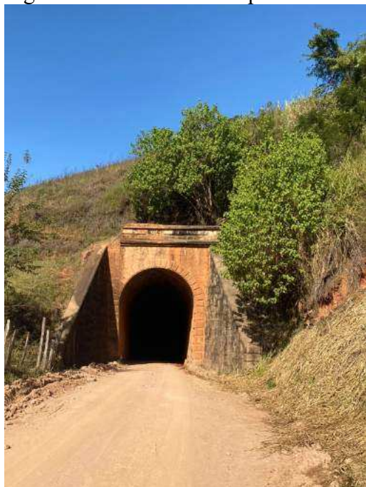
Figura 170 – Túnel da Leopoldina Railway
