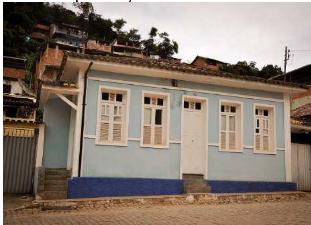
Figura 115 – Prédio da Antiga Subdelegacia – antes da requalificação
