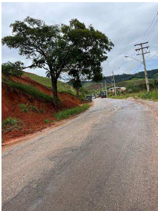
Figura 25 – Trecho da saída em Manhuaçu
