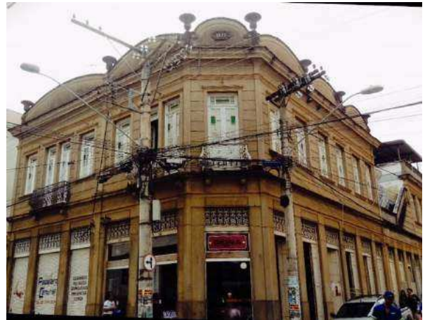
Figura 236 – Casarão na esquina da Rua Santa Luzia Com Rua Xenofonte Mercadante
