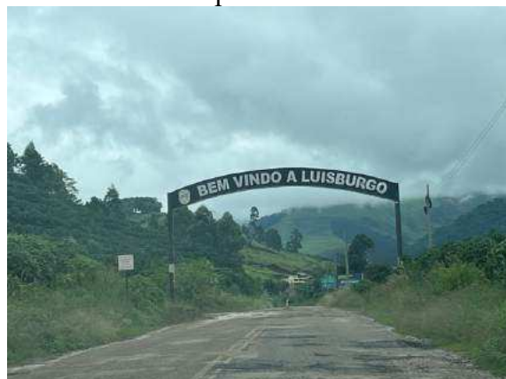
Figura 43 – Pórtico da entrada de Luisburgo com asfaltamento precário
