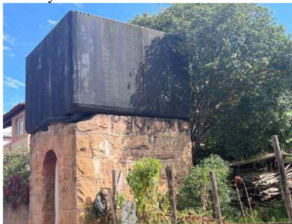
Figura 220 – Caixa D'água da Leopoldina Railway
