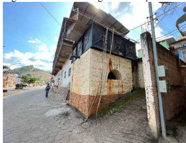
Figura 189 – Caixa D'água da Estação
