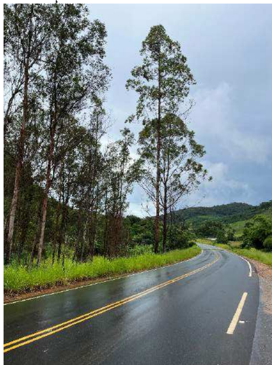
Figura 26 – Trechos recapeados com sinalização
