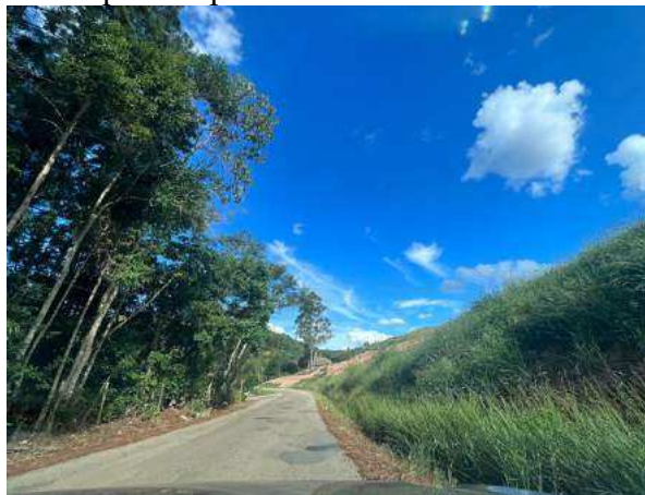
Figura 29 – Ausência de sinalização no trecho para Caparaó
