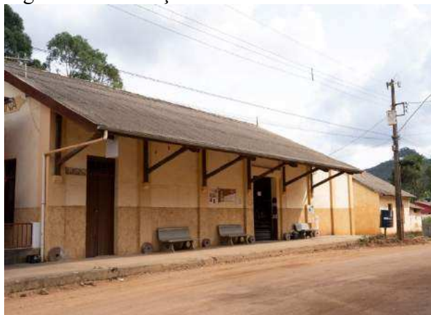
Figura 210 – Estação de Pedra Menina
