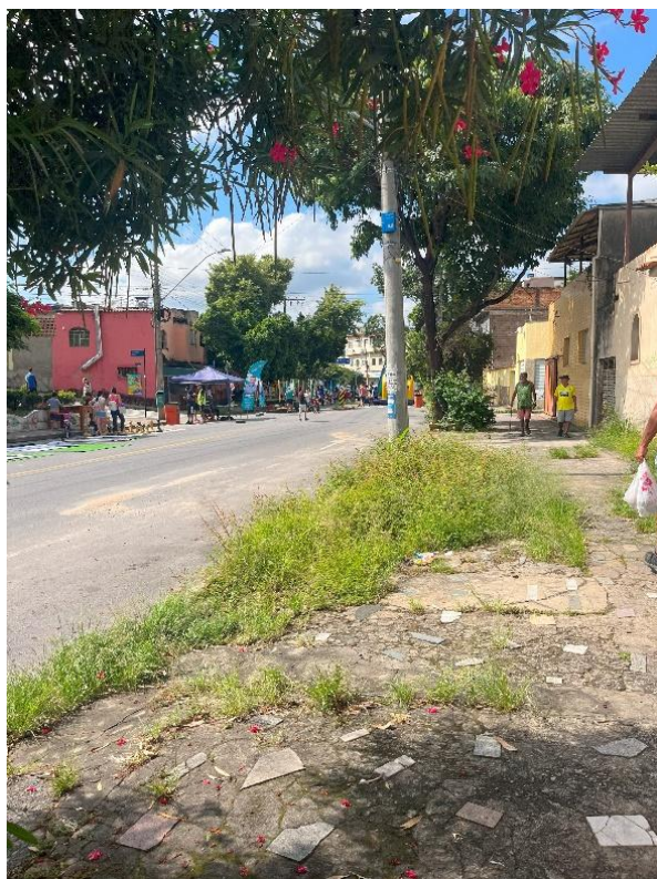
Figura 29: Situação da calçada na unidade Sagrada Família (regional Leste) do programa A Rua é Nossa
