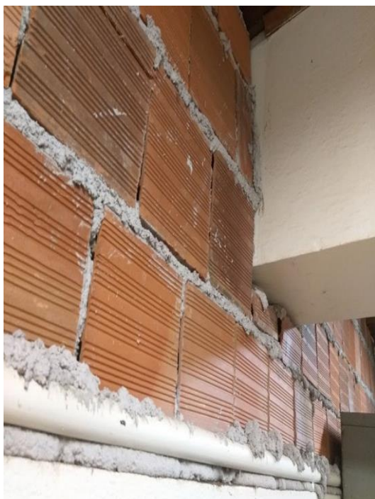
Imagem 5. Sala de depósito – Parte da reforma
