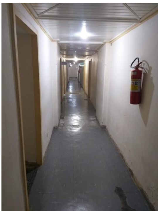
Imagem 1. Corredor do Subsolo do Edifício Arthur Bernardes - “Bernardão”
