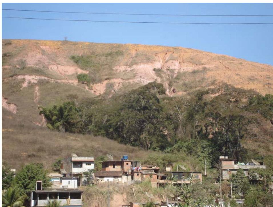
Figura 25. Área em avançado estado de degradação, Cataguases - MG
