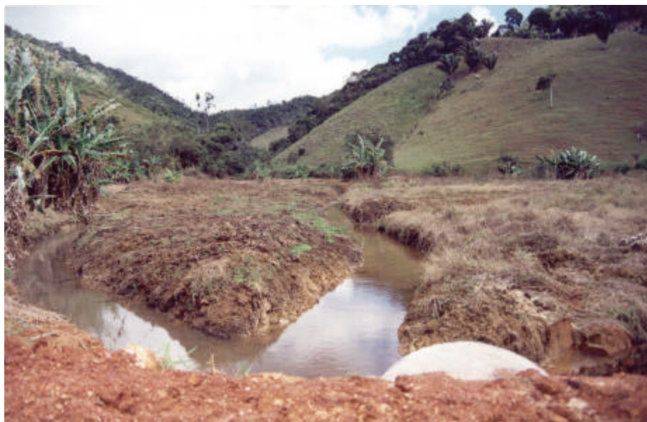
Figura 13 – Drenagem de várzea na microbacia córrego do Limão.
