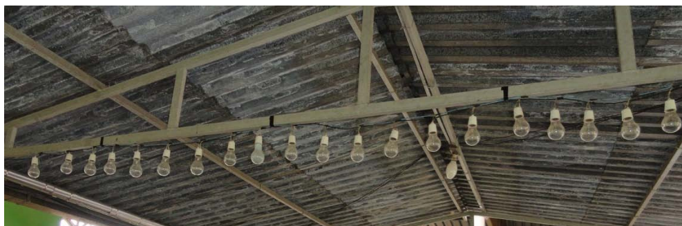
Figura 5. Conjunto para dissipação da energia elétrica do GG 1.
