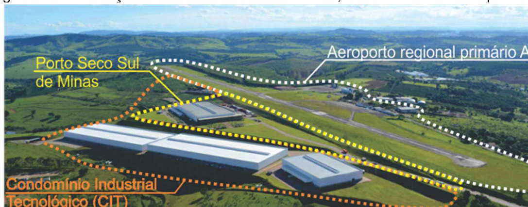
Figura 15 - Instalação do Porto Seco Sul de Minas, ao lado do sítio aeroportuário
