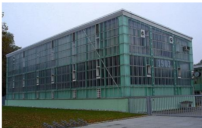
Figura 1 - Fábrica com fachada dupla. Giengen, Alemanha.
