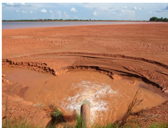
Fotografia 1. Deposição do rejeito em tanque definitivo no pátio industrial da empresa.
