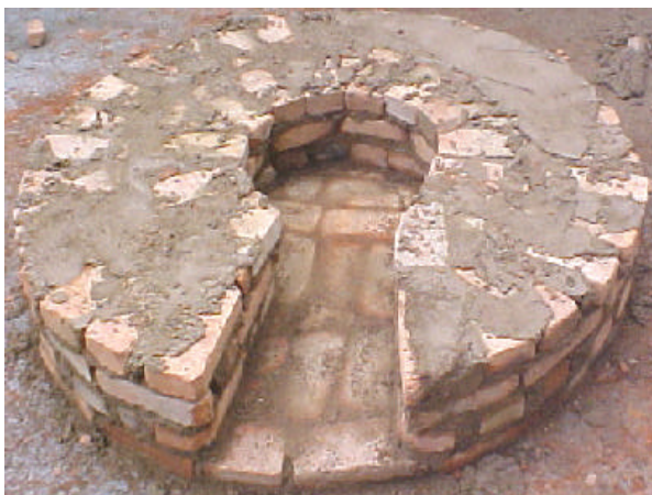
Figura 7 - Construção do cinzeiro.
