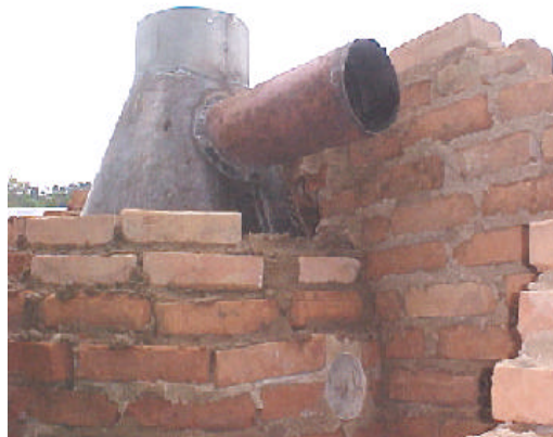
Figura 18 - Duto de ligação da câmara de combustão com a caixa coletora de ar aquecido.
