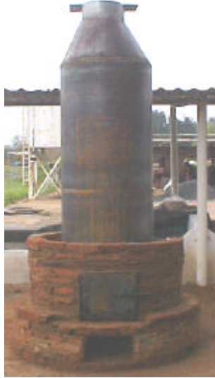
Figura 13 - Construção da parede externa da fornalha.
