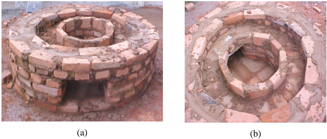
Figura 9 – Construção do cinturão de areia (a). Vista superior do cinturão (b).
